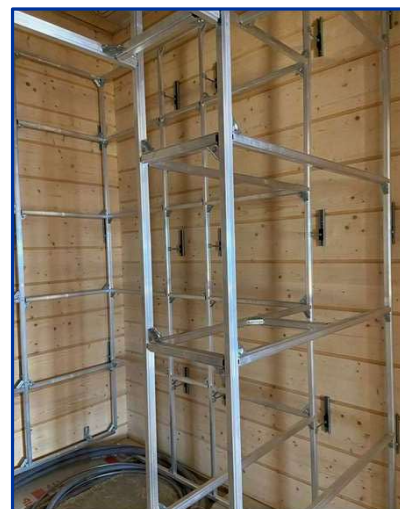
Пример установки скользящих опор WB90123 на объекте
