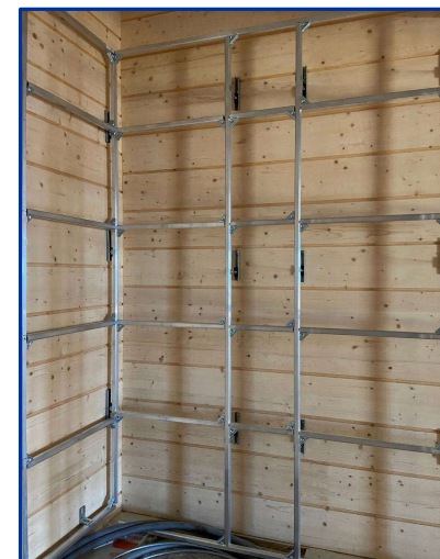
Пример установки скользящих опор WB90123 на объекте
