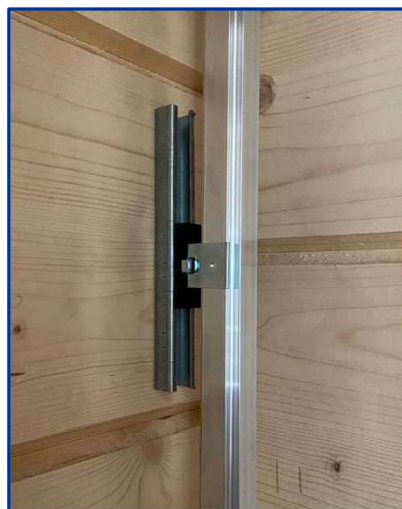
Пример установки скользящих опор WB90123 на объекте
